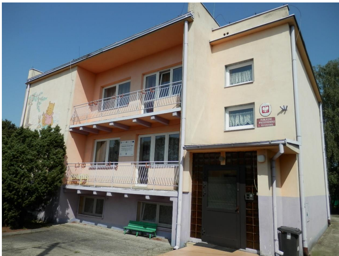
Elewacja frontowa południowa budynku z wejściem głównym.
