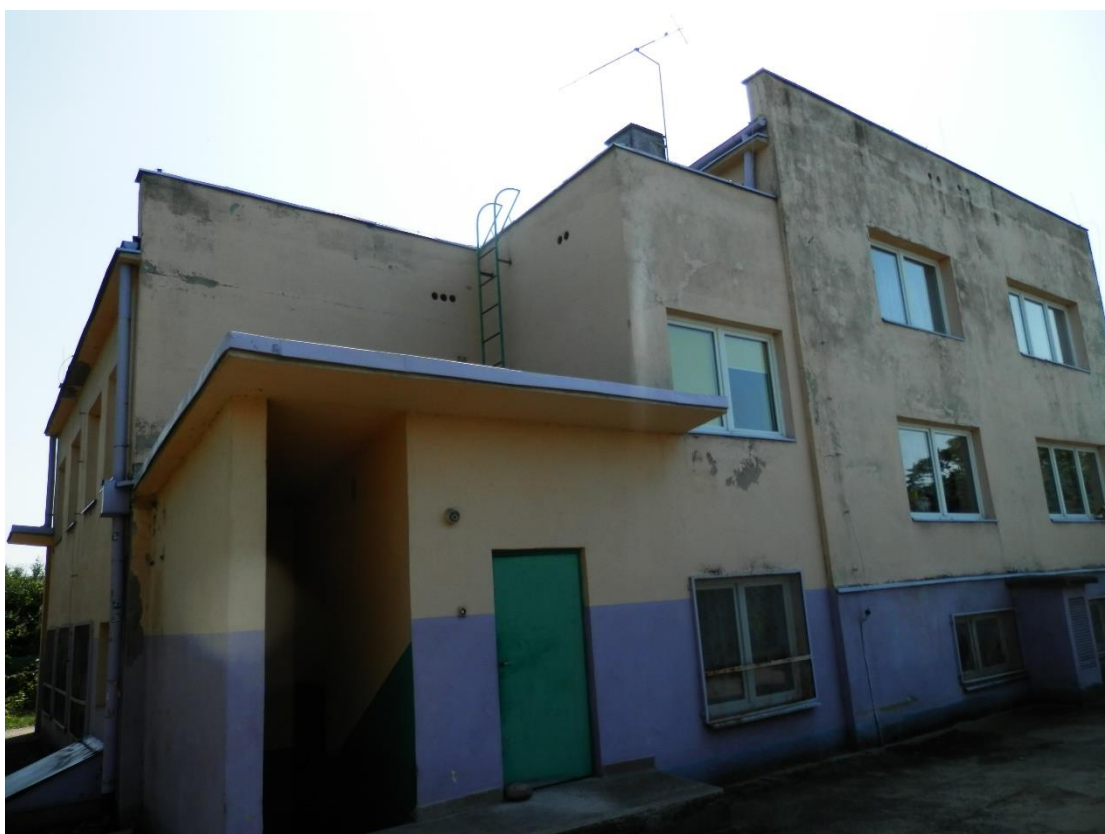
Elewacja szczytowa budynku - zachodnia.
