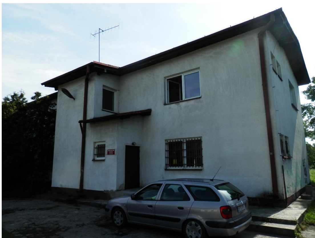
Elewacja podłużna oficyny - zachodnia.
