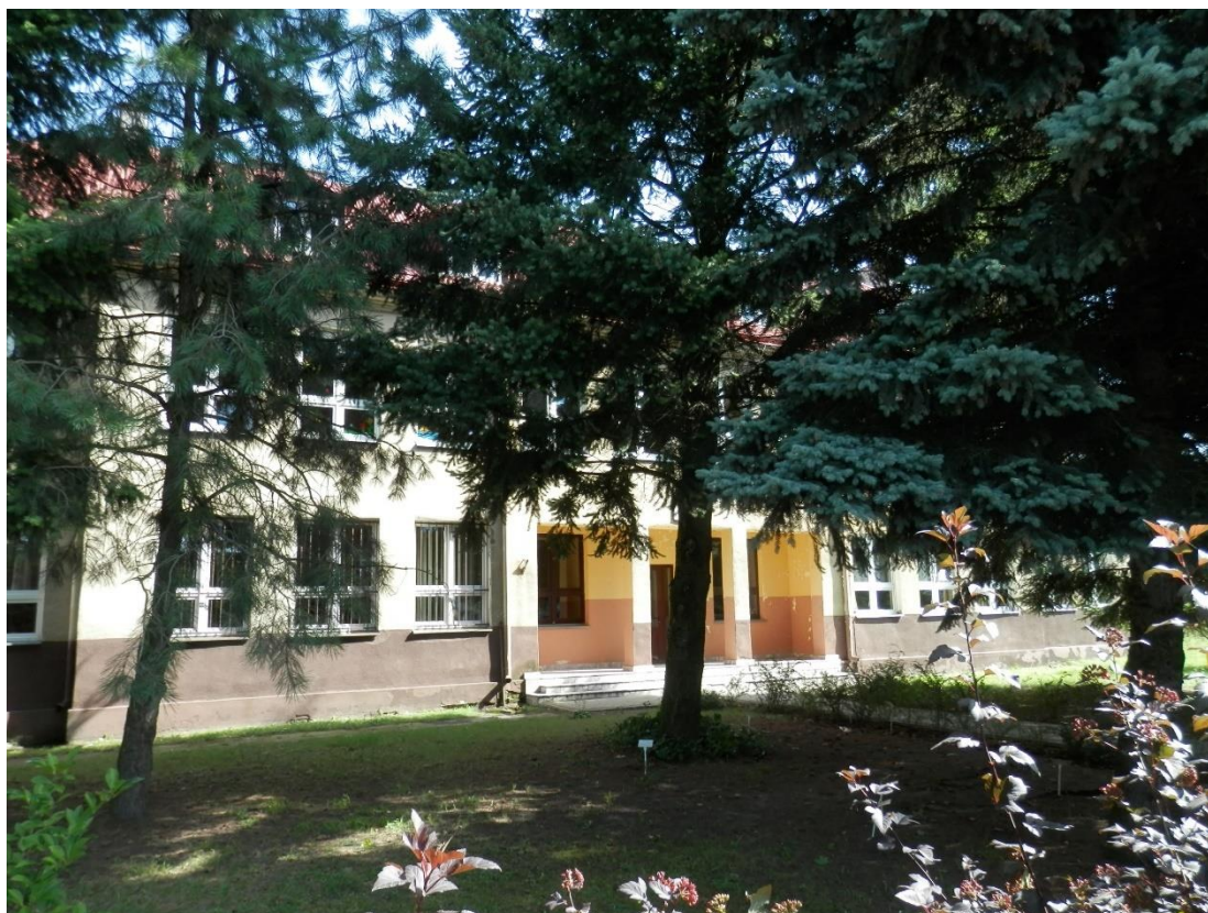
Elewacja frontowa południowa budynku z wejściem głównym.
