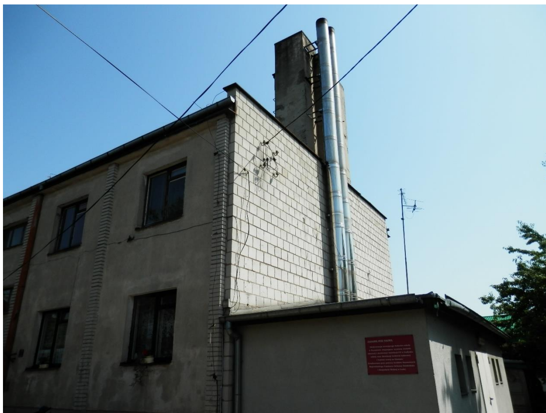
Budynek nauczycielski z kotłownią wspólną dla całego zespołu szkolnego.
