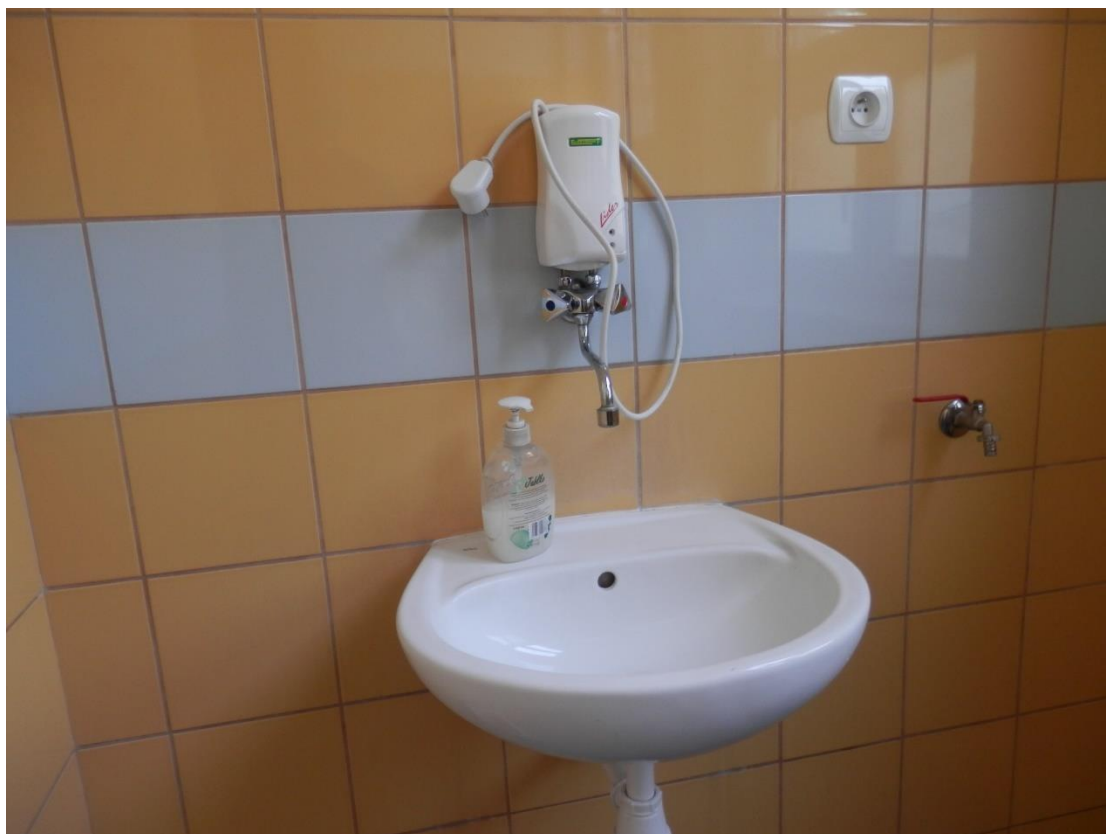
Elektryczny przepływowy podgrzewacz c.w.u. nad punktem poboru w pomieszczeniu sanitarnym na poziomie parteru budynku.
