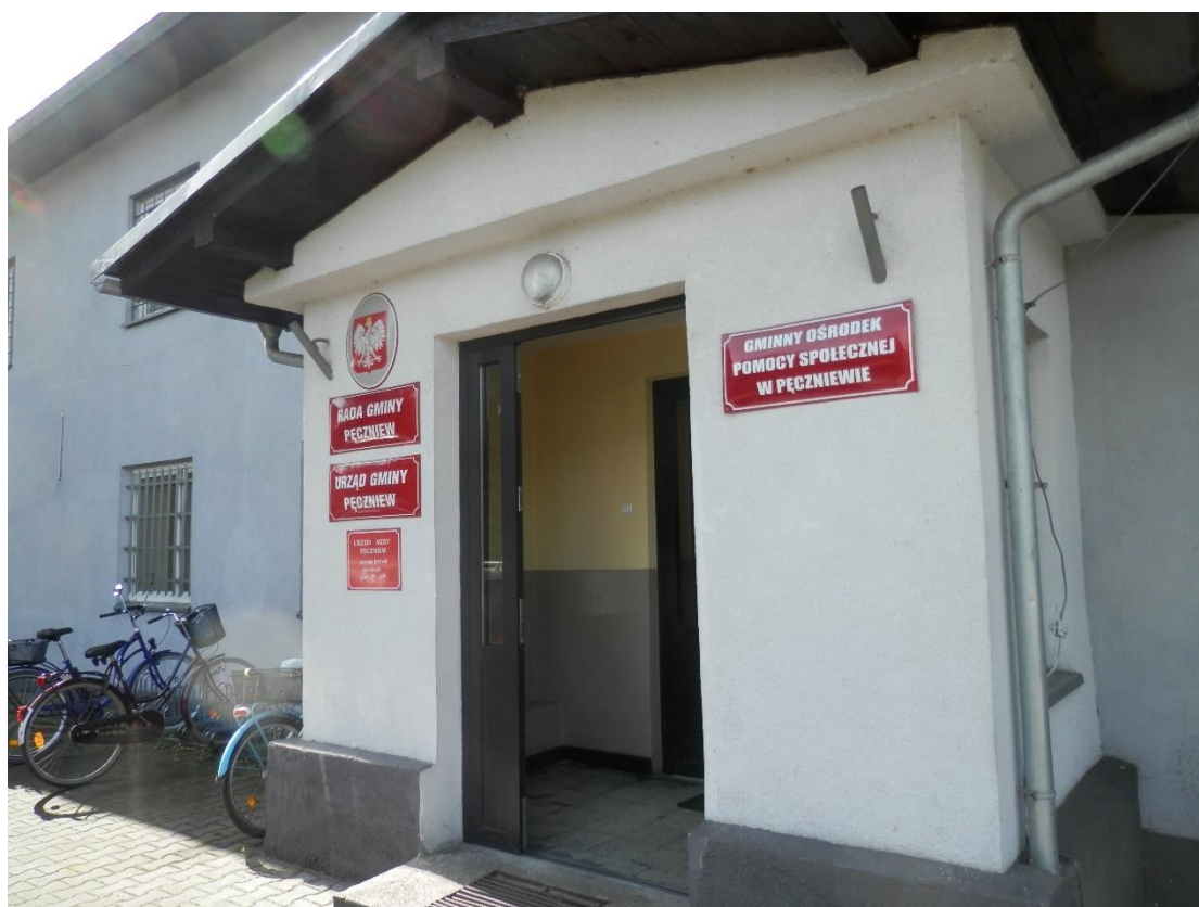
Wejście główne do budynku.
