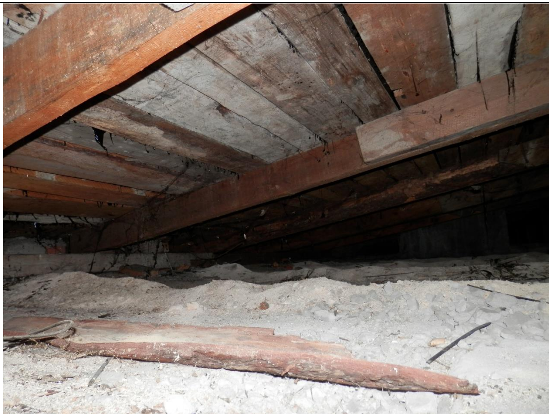
Konstrukcja i deskowanie dachu - od wnętrza poddasza.
