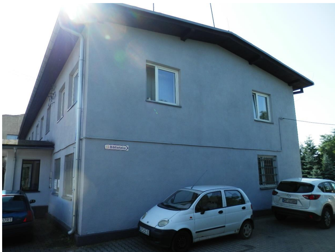
Elewacja szczytowa budynku, zachodnia.
