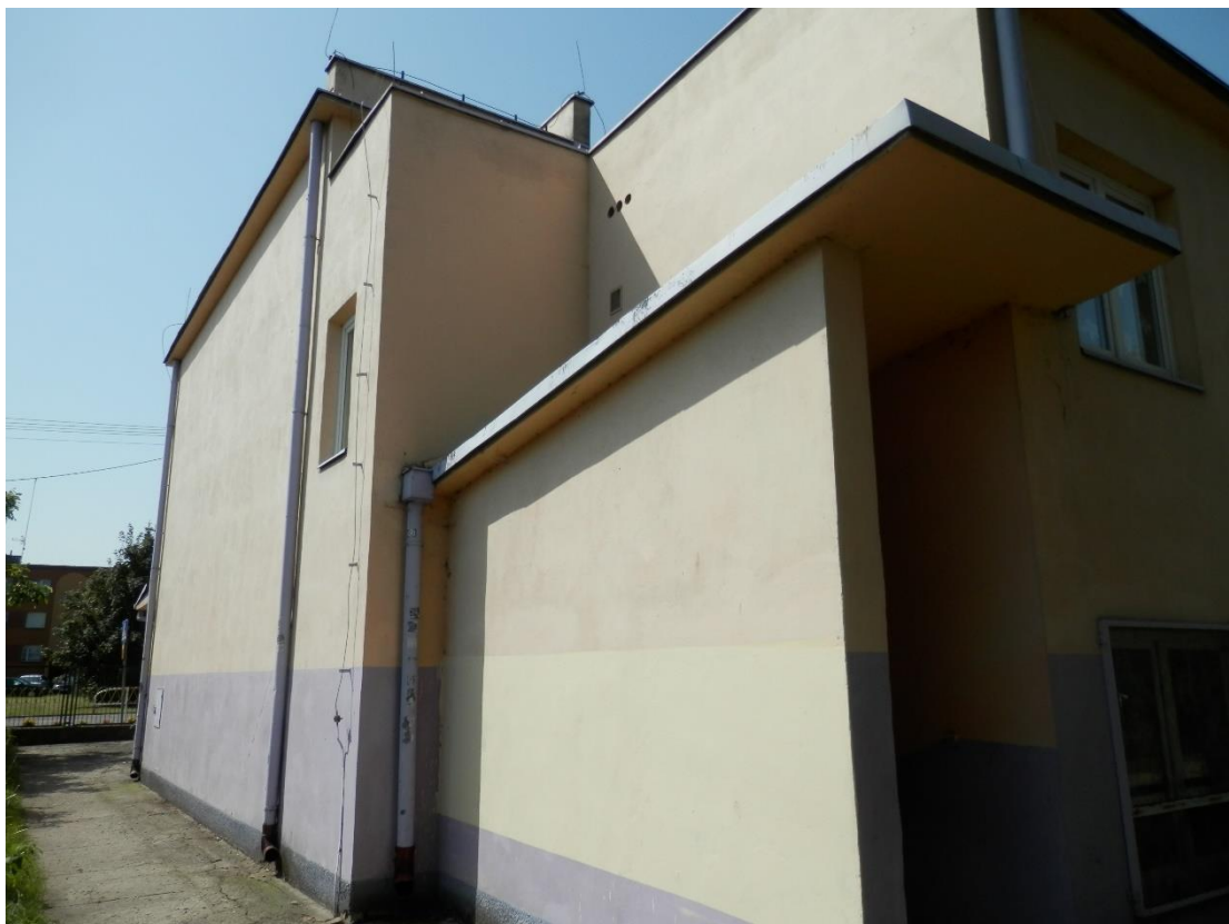
Elewacja szczytowa budynku - wschodnia.
