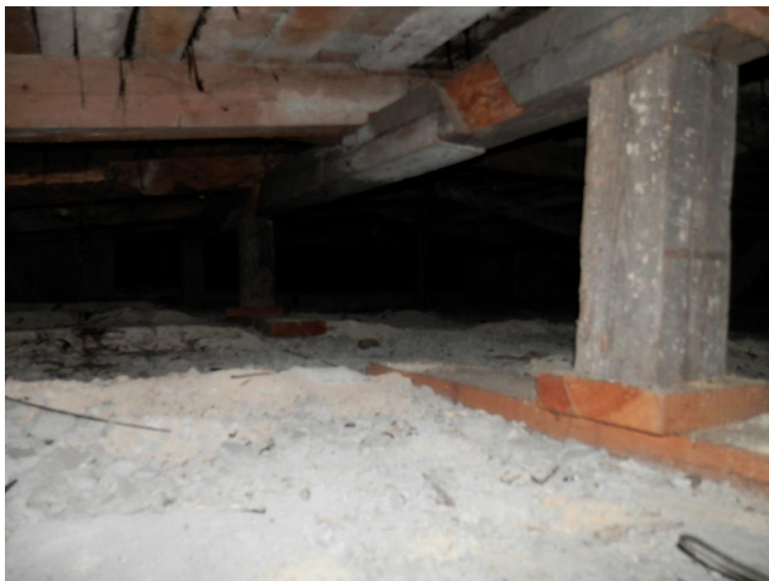
Konstrukcja dachu na stropie Kleina.
