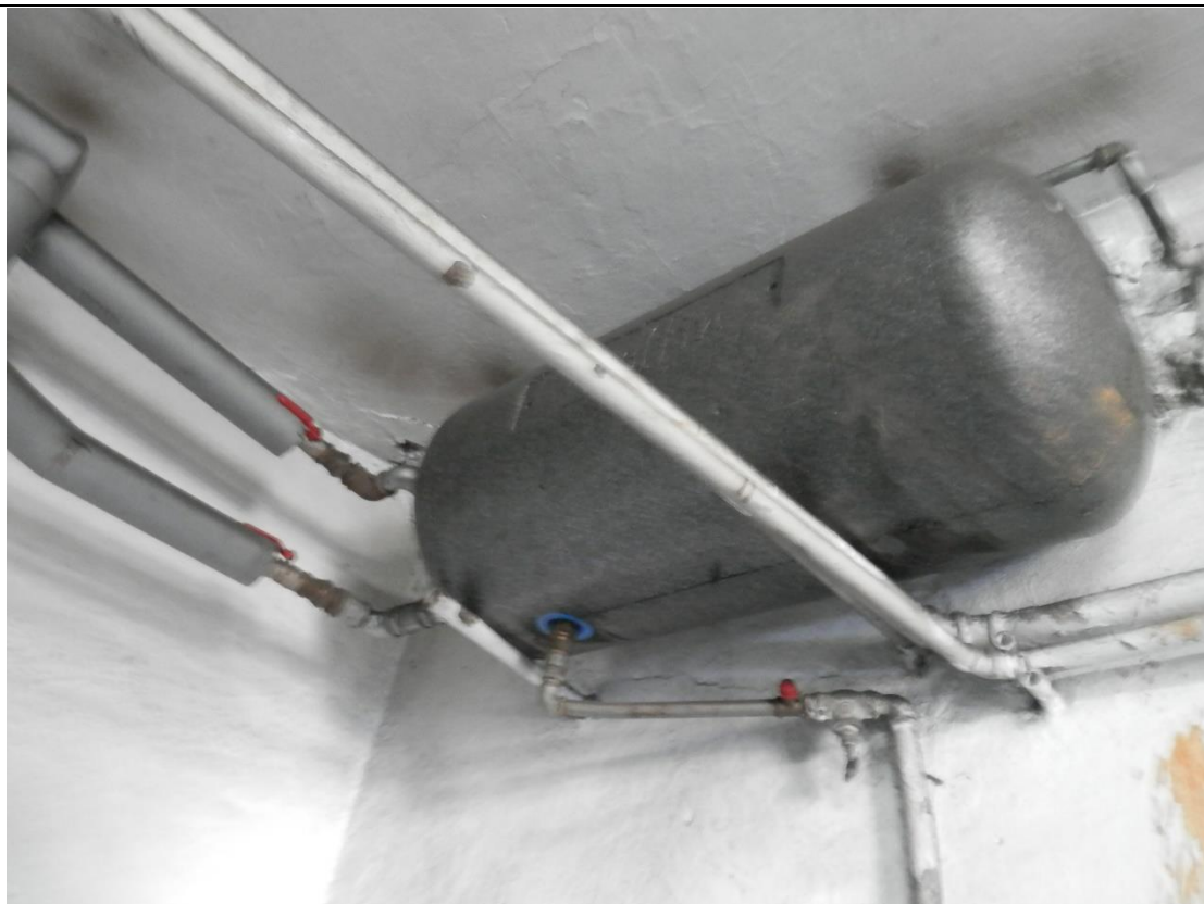
Zasobnikowy podgrzewacz c.w.u. zasilany z kotła.
