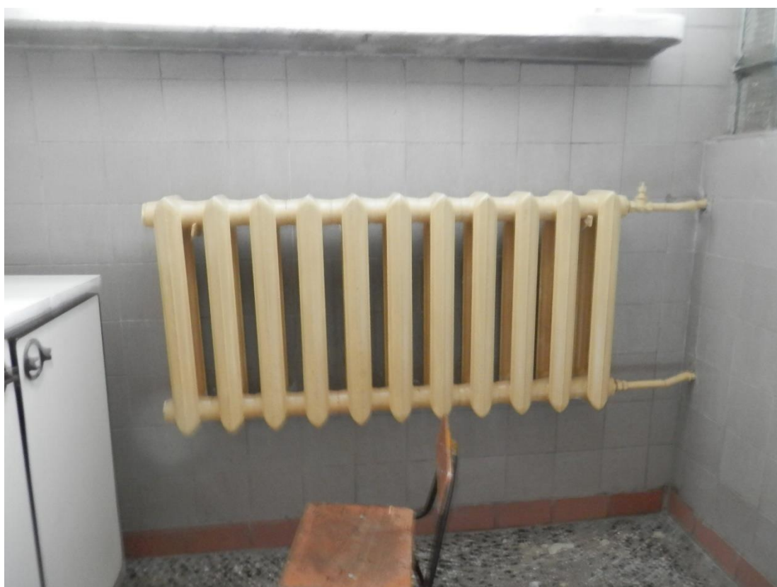
Grzejnik żeliwny członowy w systemie grzewczym budynku.
