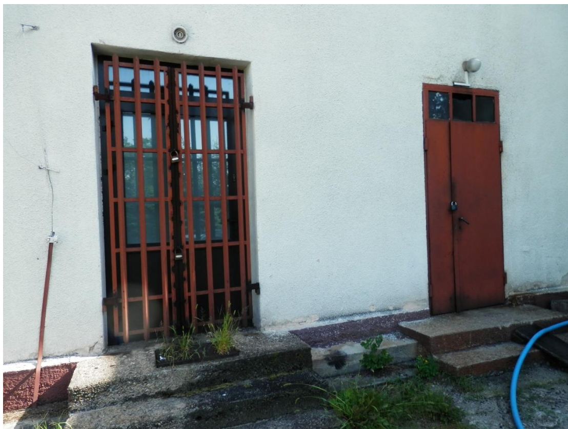
Wejście zapasowe oraz wejście do kotłowni.
