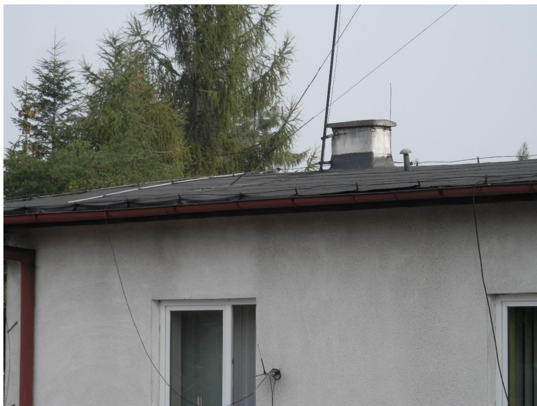
Widok na fragment dachu budynku obrazujący stan pokrycia.
