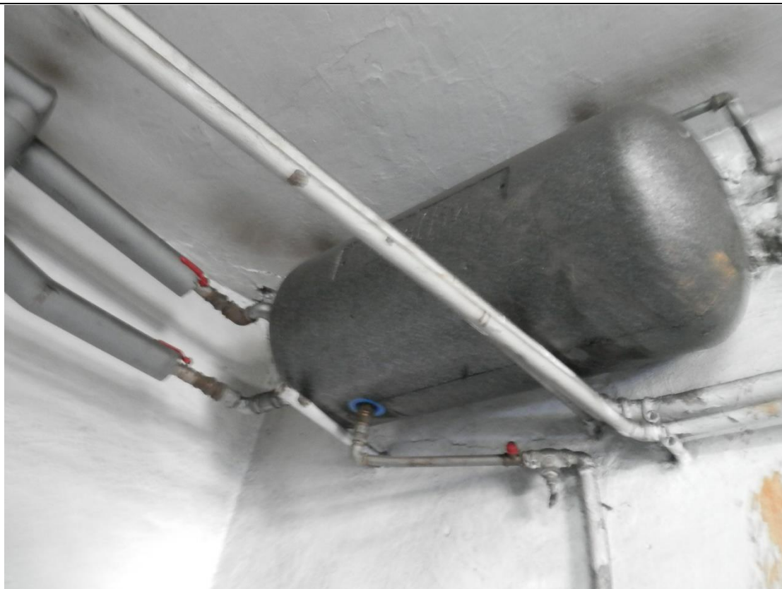
Zasobnikowy podgrzewacz c.w.u. zasilany z kotła.
