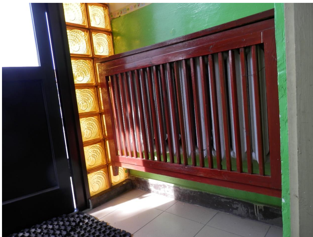
Grzejnik żeliwny członowy w systemie grzewczym budynku.
