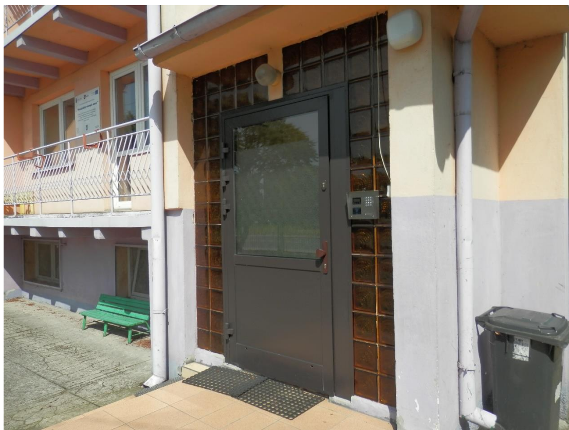
Wejście główne do budynku przedszkola.
