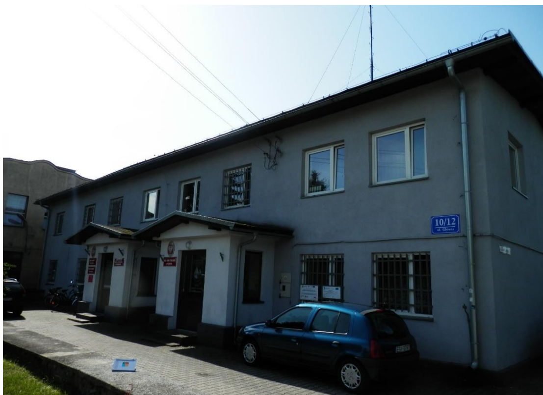
Elewacja frontowa północna budynku z wejściem głównym
