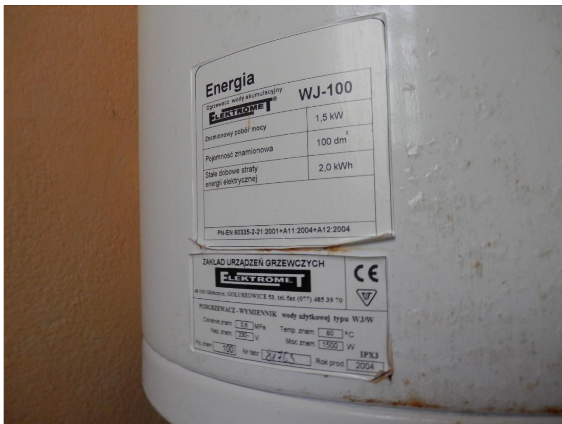
Tabliczka znamionowa podgrzewacza wody.
